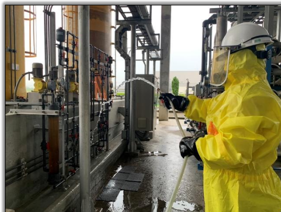
PO ตัดแยกระบบท่อ Discharge Pump NaOCl No.2 และทำความสะอาดพื้นที่
