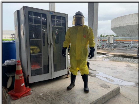
PO สวมใส่อุปกรณ์ PPE เตรียมเข้าตัดแยกระบบท่อ Discharge Pump NaOCl No.2 และทำความสะอาดพื้นที่
