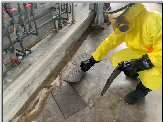
PO ตัดแยกระบบท่อ Discharge Pump NaOCl No.2 และทำความสะอาดพื้นที่
