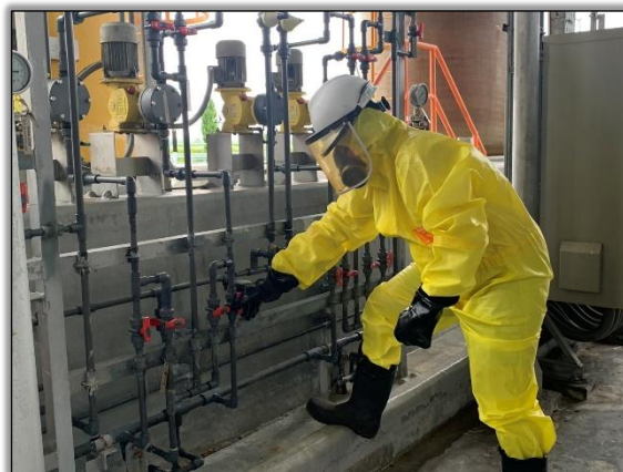
PO สวมใส่อุปกรณ์ PPE เตรียมเข้าตัดแยกระบบท่อ Discharge Pump NaOCl No.2 และทำความสะอาดพื้นที่
